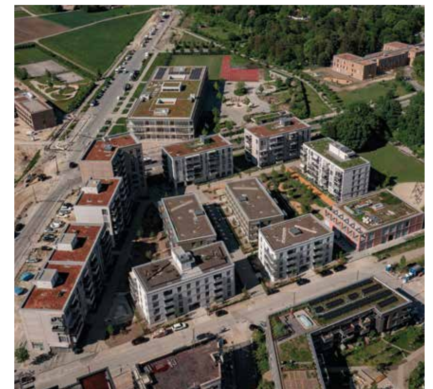
Blick auf die Grundschule Aubinger Allee / Hörweg
